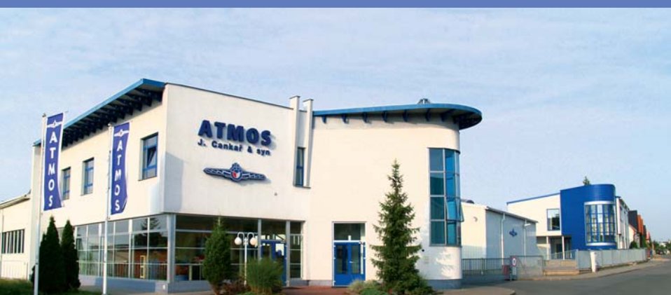
Производственный комплекс ATMOS-1
